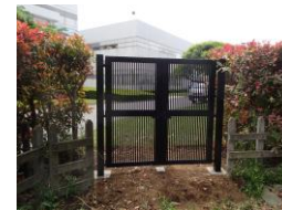
出入口の門を確認
